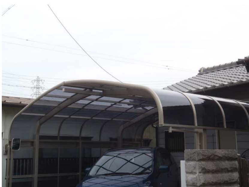
K様邸カーポート工事
