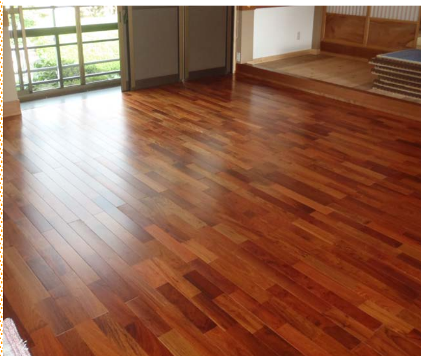
S寺本堂改修工事 床：花梨無垢材 捨貼：杉赤材
