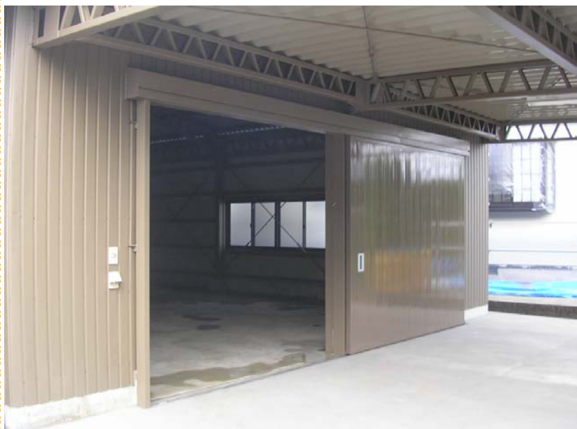
Y邸様農業用倉庫新築工事 軽量鉄骨造平屋建 屋根：大波スレート葺き 外壁：角波ガルバニウム鋼板
